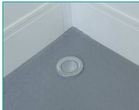
Ilustración 5. Desagüe cerrado
